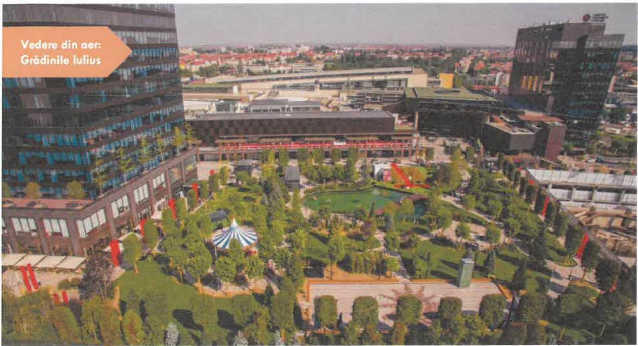
United Business Center 3 – Clădire de birouri și parcare VIP
